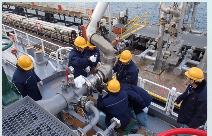
陸上パイプラインとの接続作業
